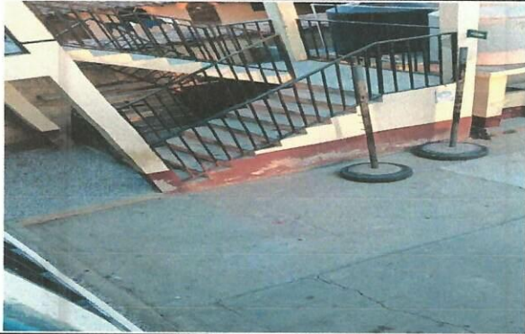
Foto1: Mejoramiento de barandales y piso antideslizante
